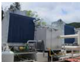
大型空調機・室外機
